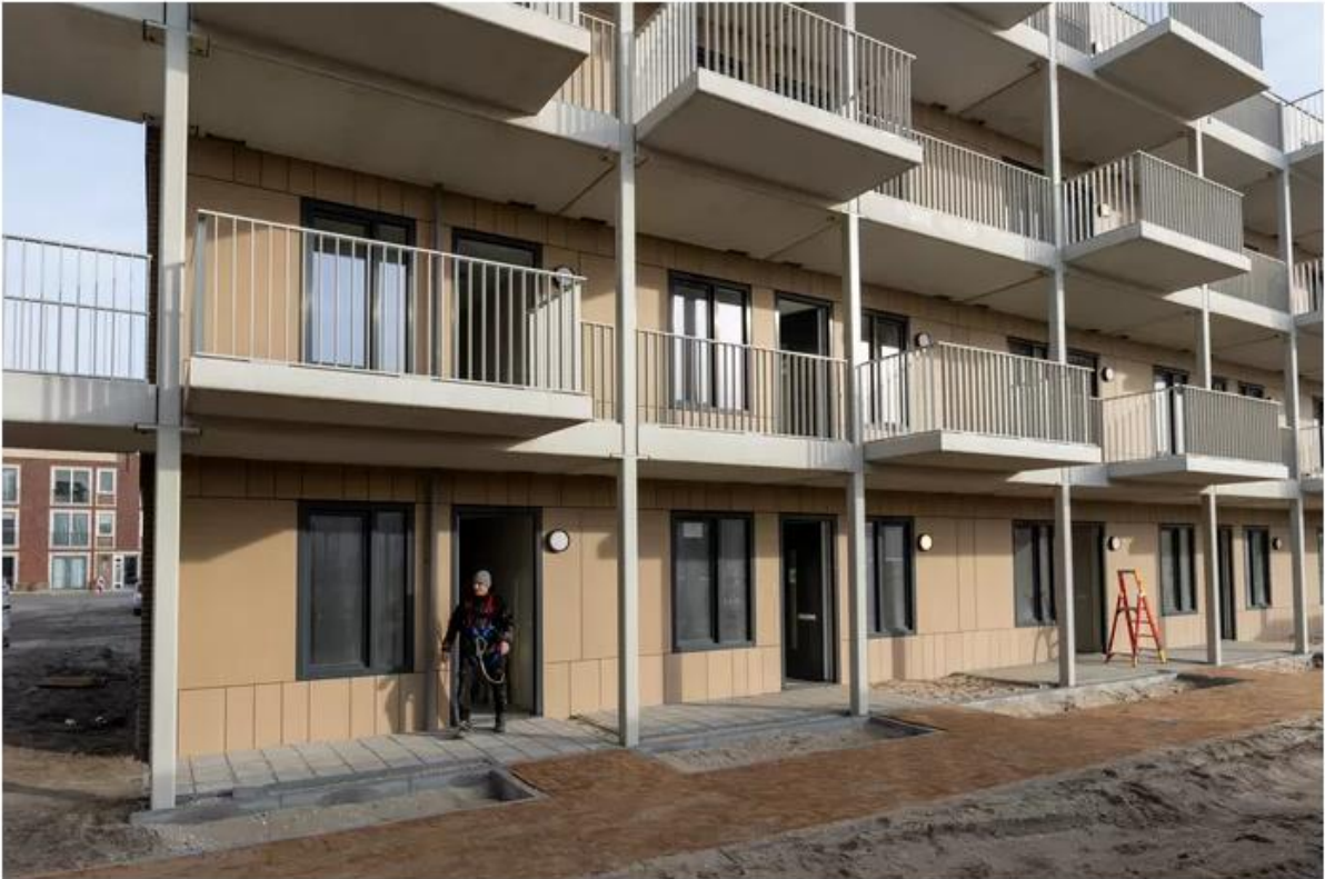
▲ De op afstand gemaakt appartementen en studio's in Tuindershof in Pijnacker zijn, op wat afwerkingen na, zo goed als klaar. © Dennis Wisse
